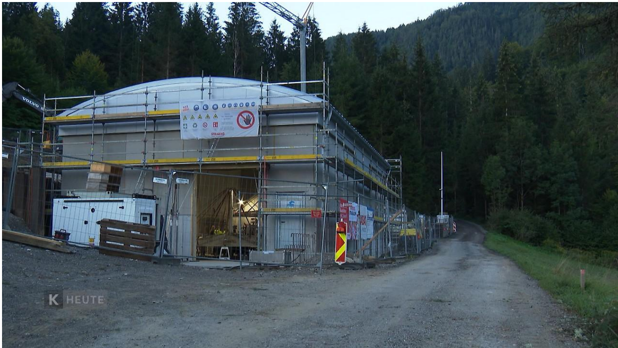
ORF Bau des neuen Hochbehälters
